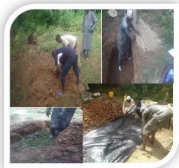
Processus de mise en fosse des matériaux compostables
